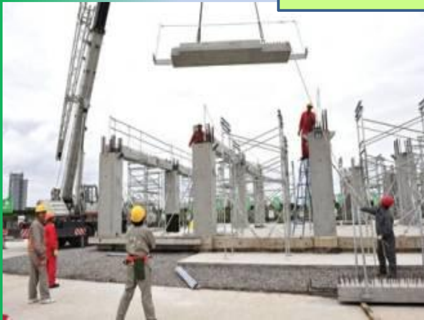
现场装配式施工（干法施工）
