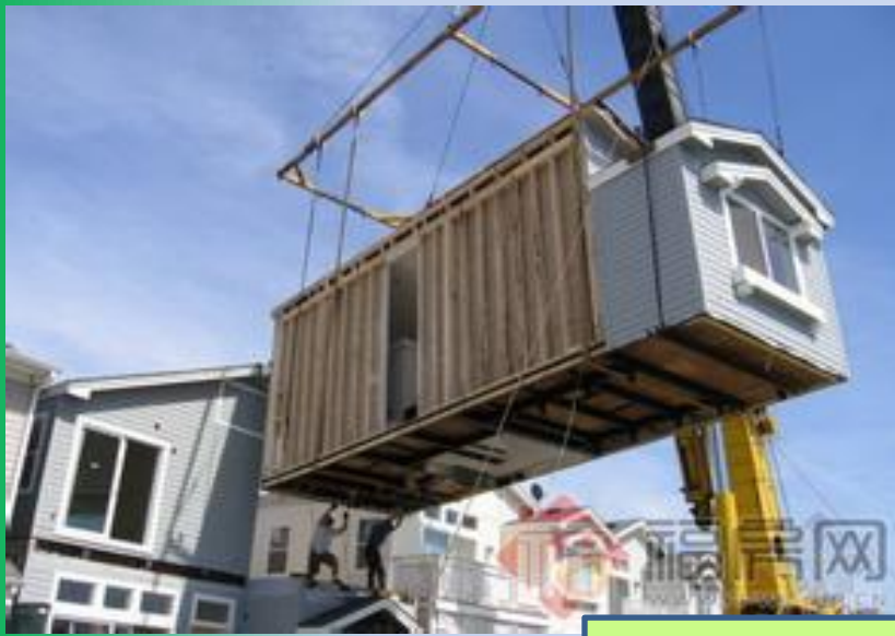
现场装配式施工（干法施工）
