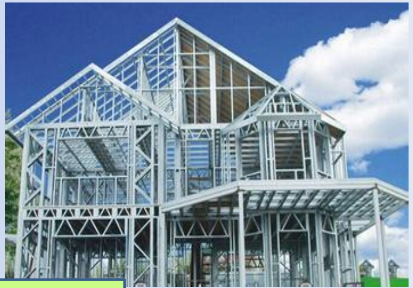
现场装配式施工（干法施工）
