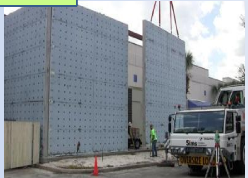
现场装配式施工（干法施工）
